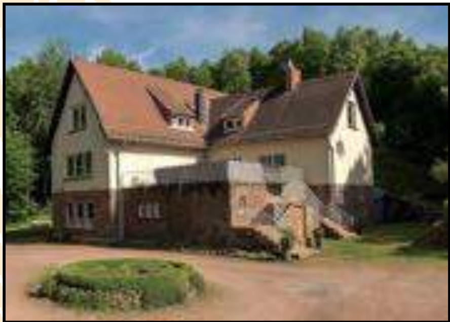
Escuela Neijing Sulzbach
